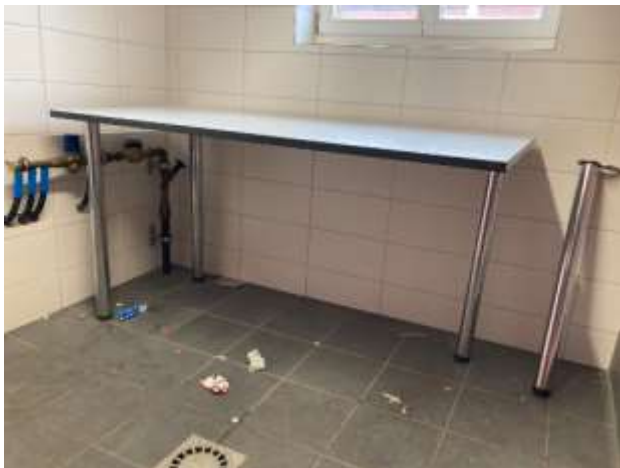
(Foto 1: Sachbeschädigung Toilettenanlage Kollerhaus)
