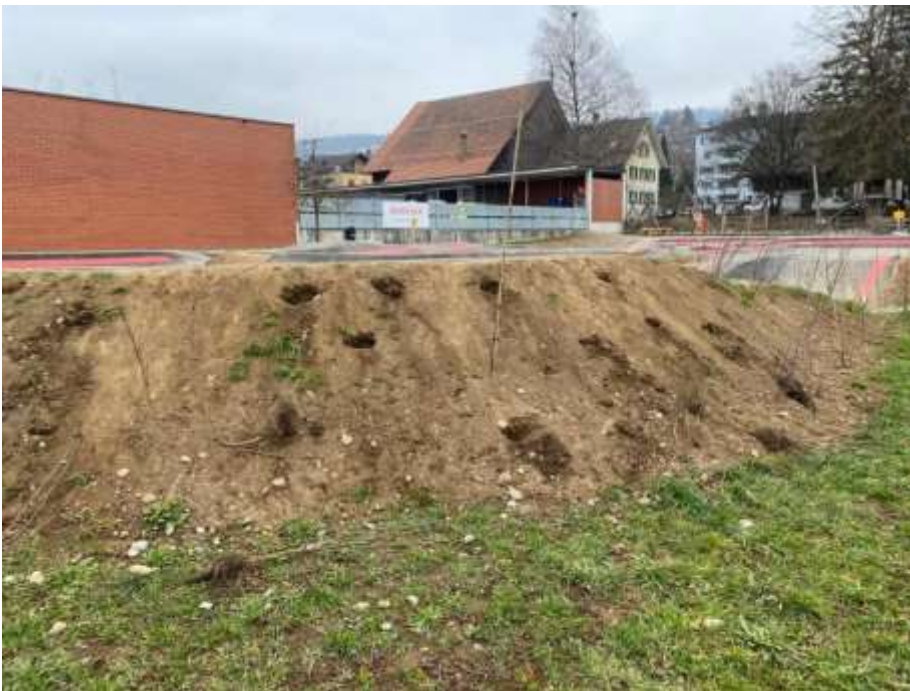
(Foto 3: Sachbeschädigung Pumptrack-Anlage)
