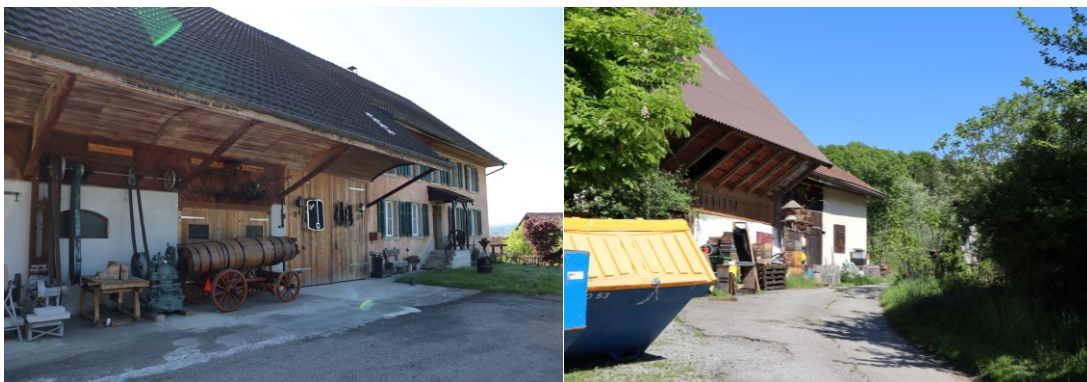
Abbildung 11: Holzrüti 13 (links) und Holzrüti 15 (rechts) (Fotos: eigene Aufnahmen)
