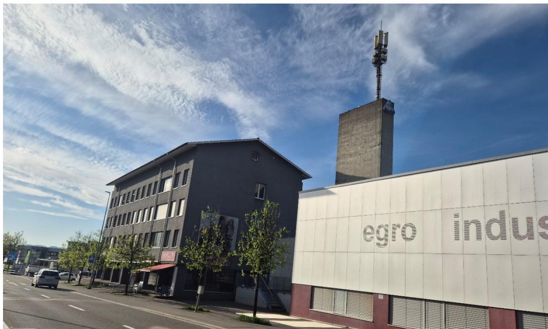
Abbildung 18: Von den Egro-Altbauten sollen der graue Kopfbau (Gebäude Nr. 129, links im Bild) sowie der Hochkamin, an welchem eine Mobilfunkantenne montiert ist, geschützt werden (Quelle: Eigene Aufnahme vom 9. April 2026).
