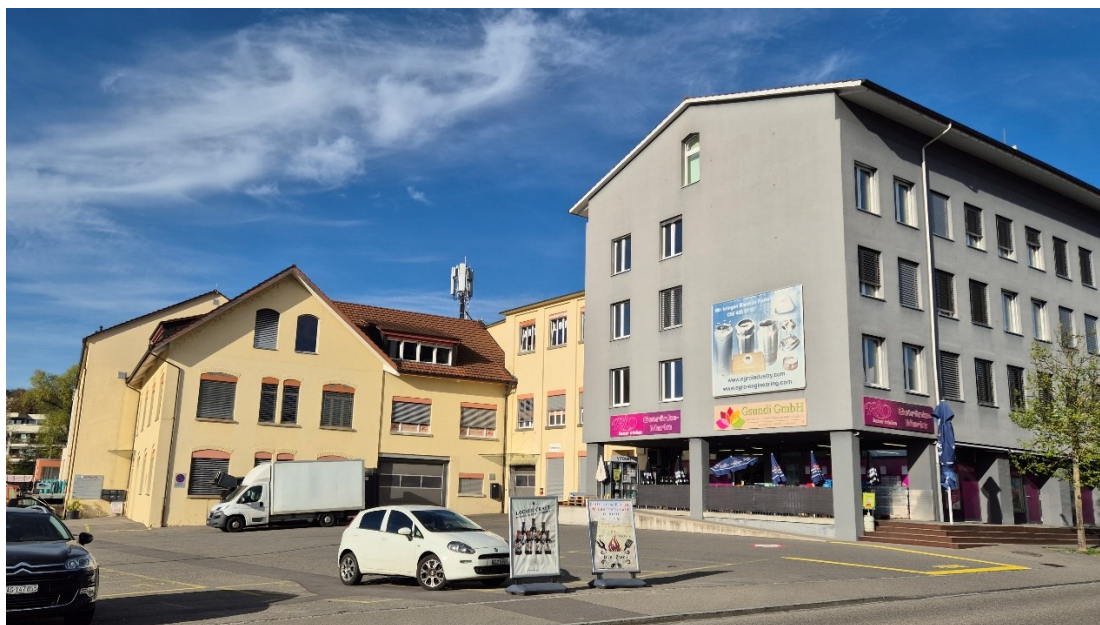
Abbildung 14: Blick von der Mellingerstrasse auf die Egro-Altbauten (beige: Westflügel, grau: Kopfbau; Quelle: Eigene Aufnahme vom 9. April 2026)
