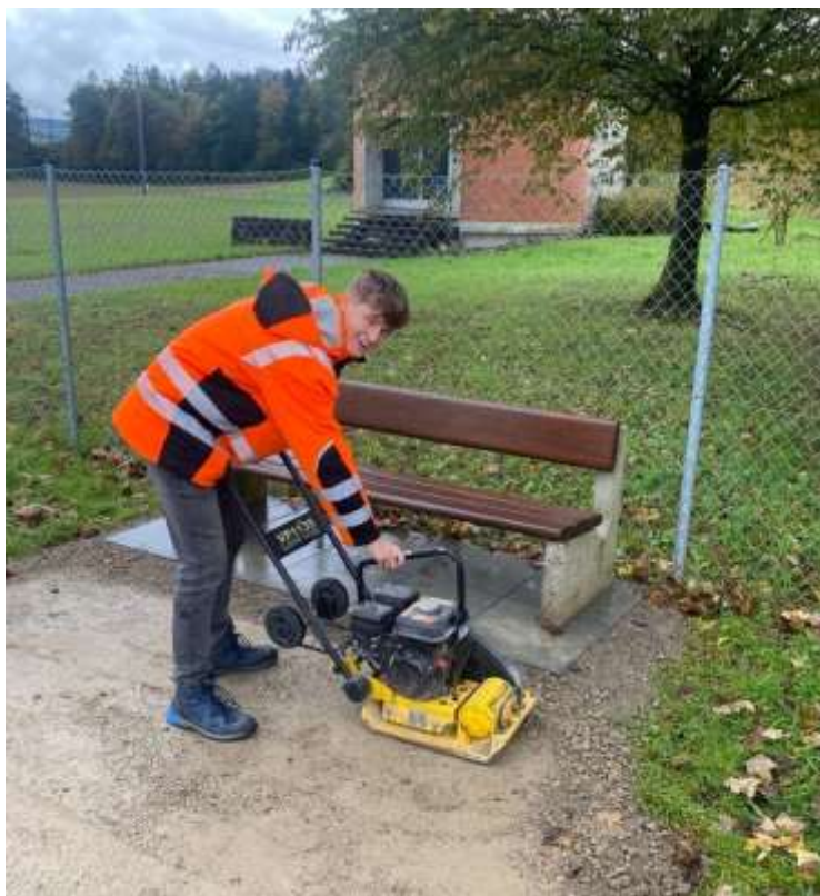
Foto 1: Sitzbank mit Fundament
