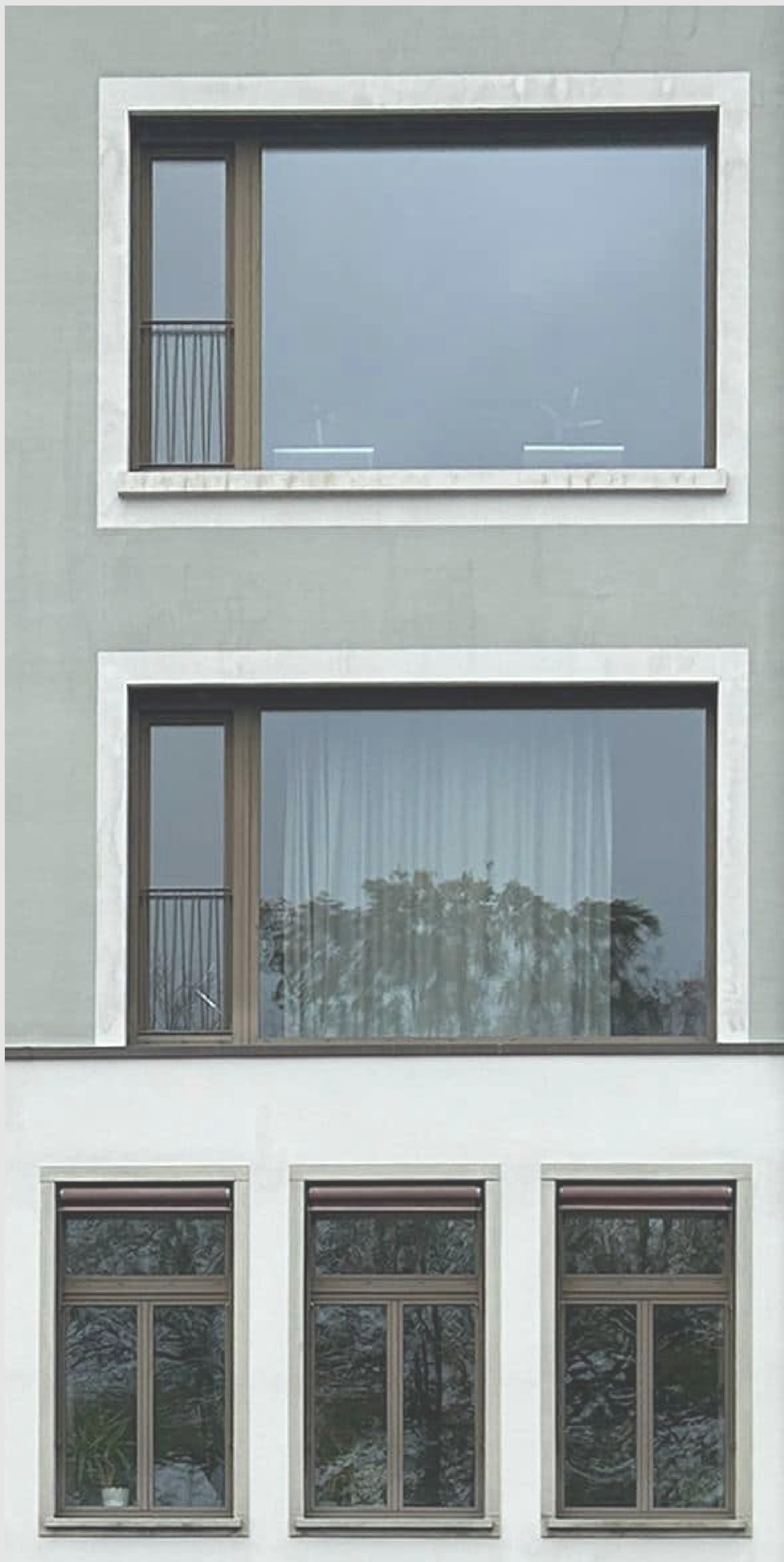
Erweiterung Oberstufenzentrum Hüslerberg, Niederrohrdorf
