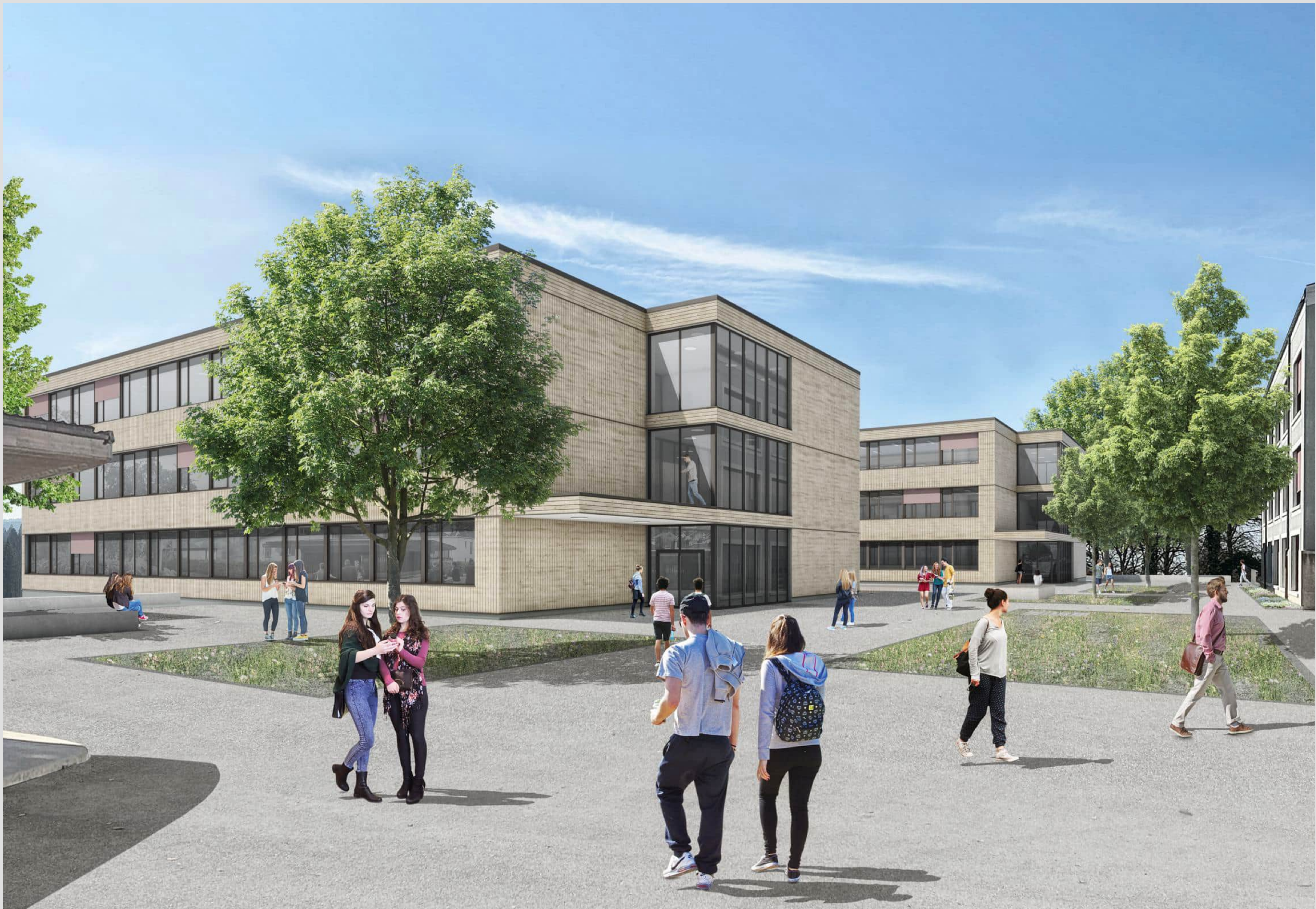
Erweiterung Oberstufenzentrum Hüslerberg, Niederrohrdorf
