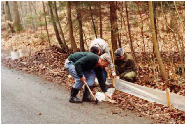
Bau der Lurchschanke an der Holzrütistrasse 1991 mit PE-Folie
