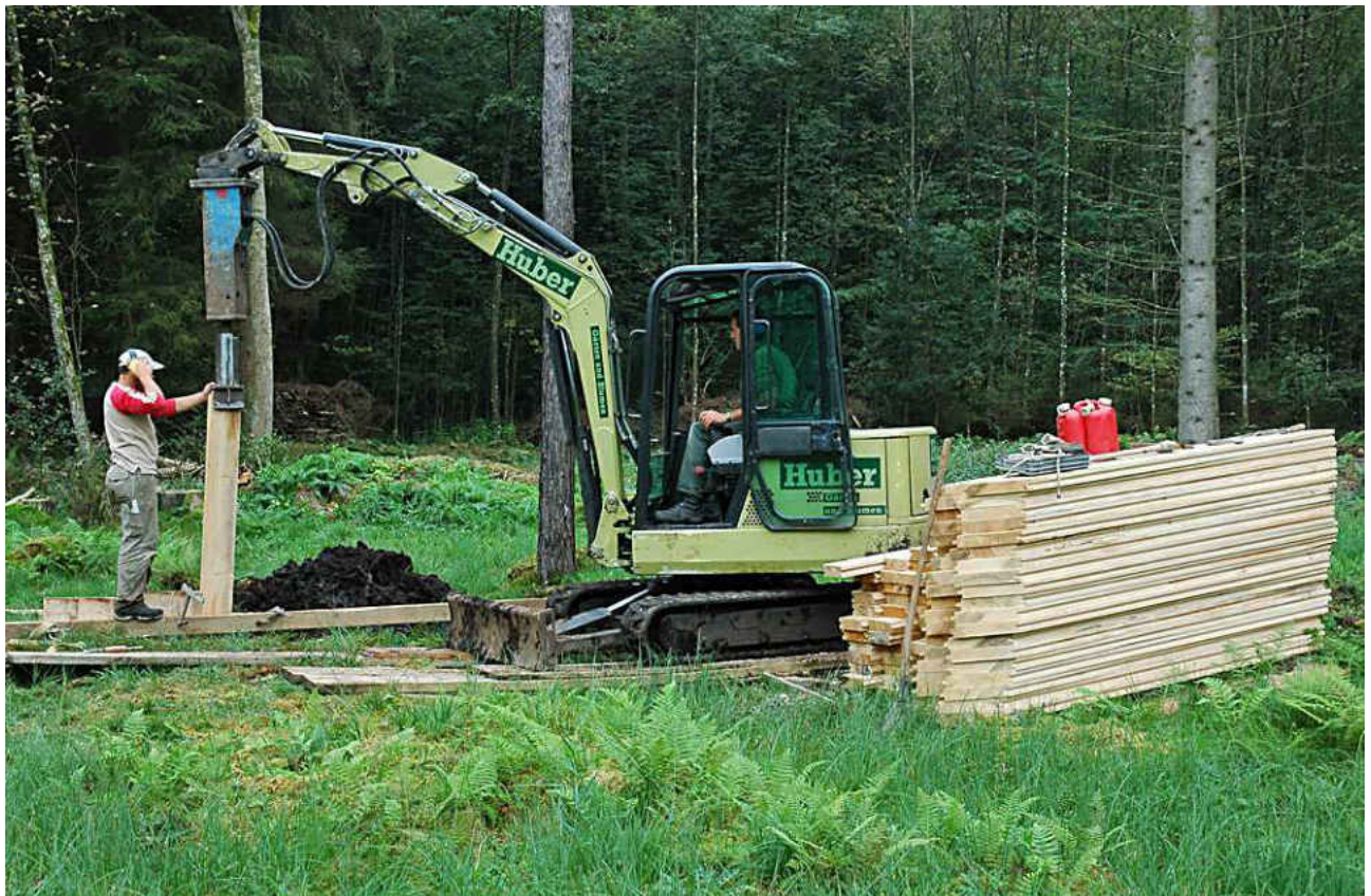
Riedwiese südlich Pumpstation Torfmoos. Spundwand setzen in seitlichem Entwässerungsgraben (28.09.2006)
