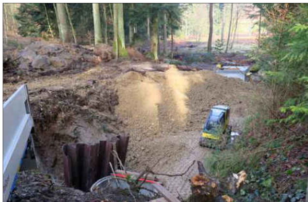
Bau des Dammes und Regulierschacht im Taumoos (25.01.2018)
