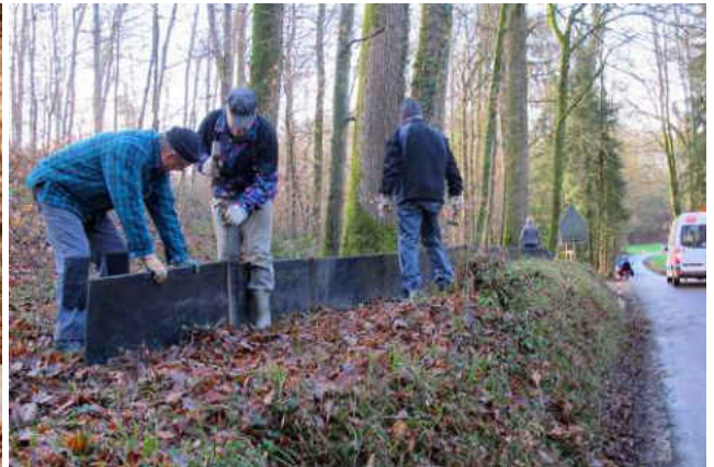
Bau der Lurchschanke an der Holzrütistrasse 2016 mit Stellplatten
