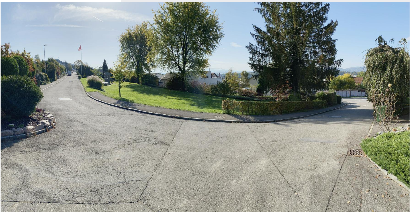
Kurve der Fohrhölzlistrasse im Bereich des öffentlichen Spielplatzes
