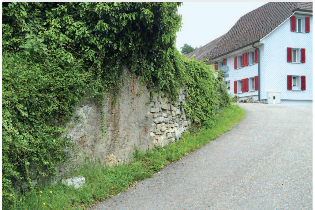
Ansicht der Stützmauer, am oberen Ende des früher sanierten Abschnittes.
