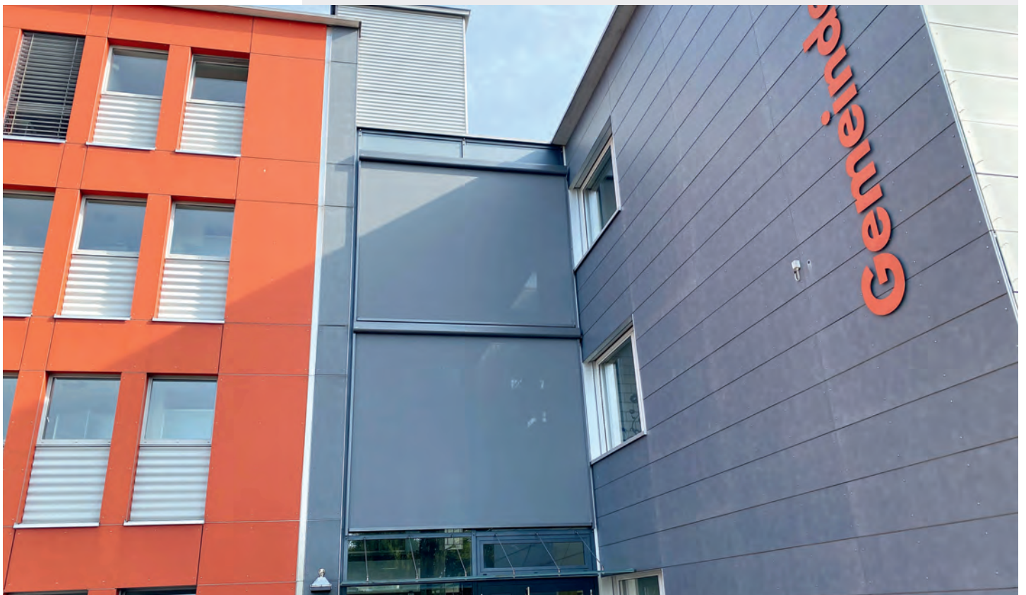
Abbildung: Eine der bereits umgesetzten Massnahmen sind die Sonnenstoren an den grossflächigen Treppenhaus-Verglasungen (Bildmitte).
